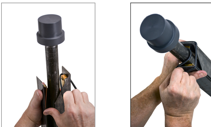
FIGURA 10: Instalación de la junta tórica
