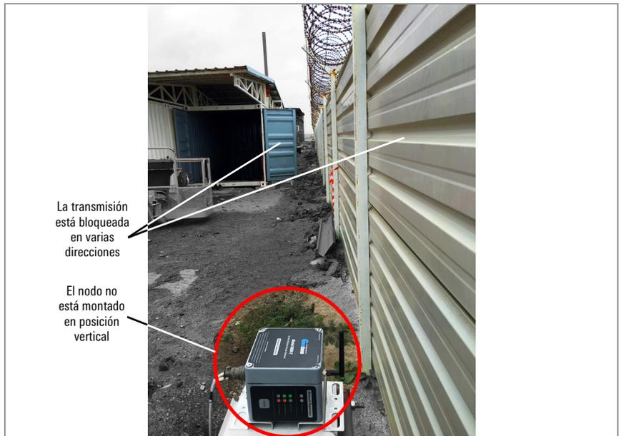
**FIGURA 19:** Instalación cerca de edificios o vallas/paredes y/o en posición horizontal
